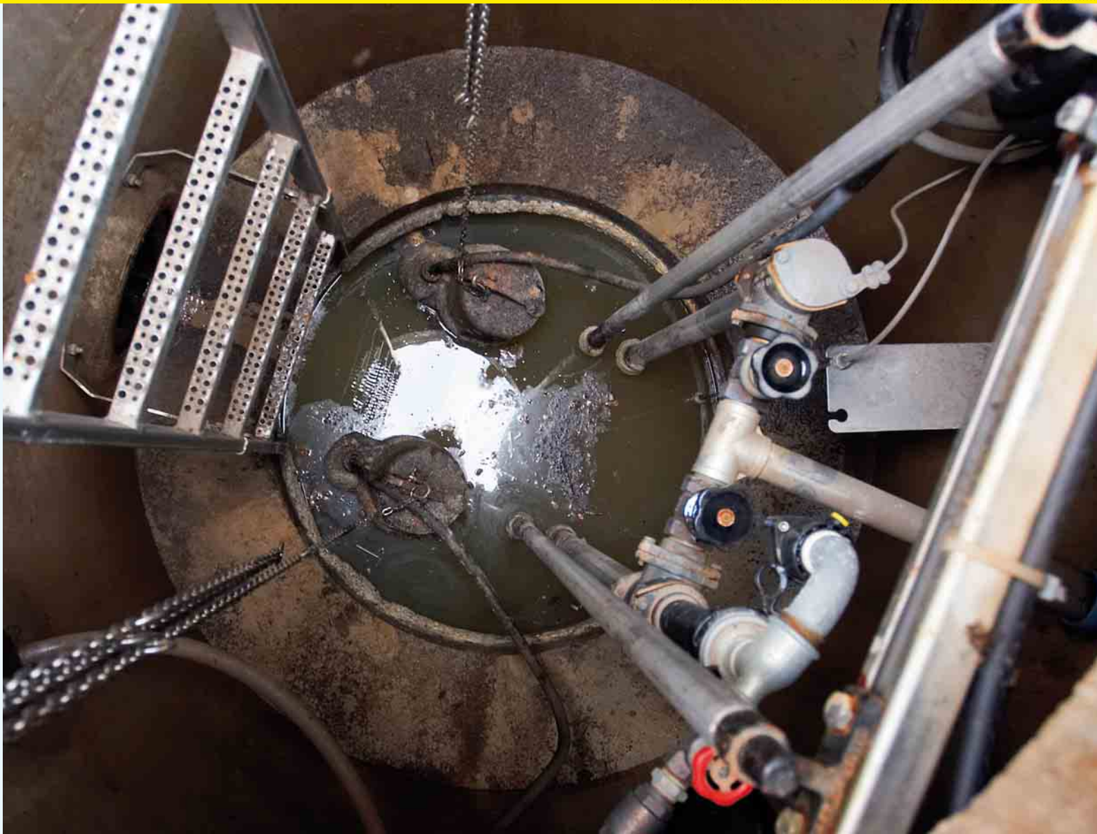
BEISPIEL: Pumpenschacht als Systemschacht
